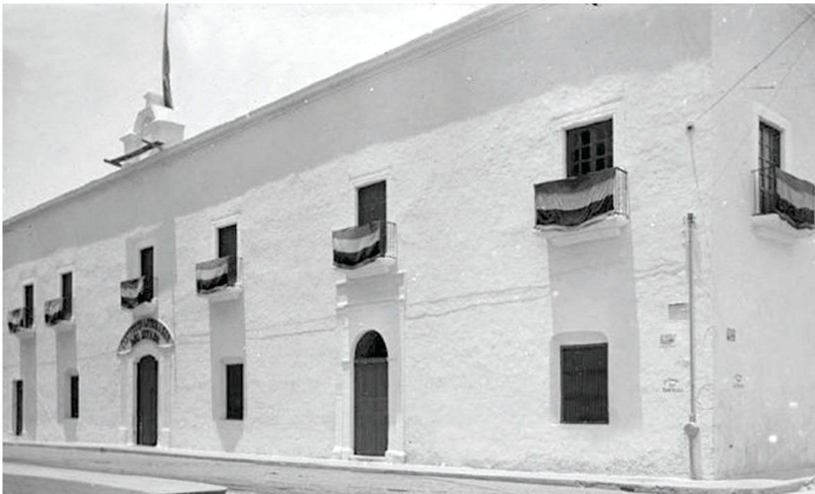
Edificio del Instituto Literario del Estado hoy Universidad Autónoma de Yucatán, calle 60 por 57, c. 1920.
