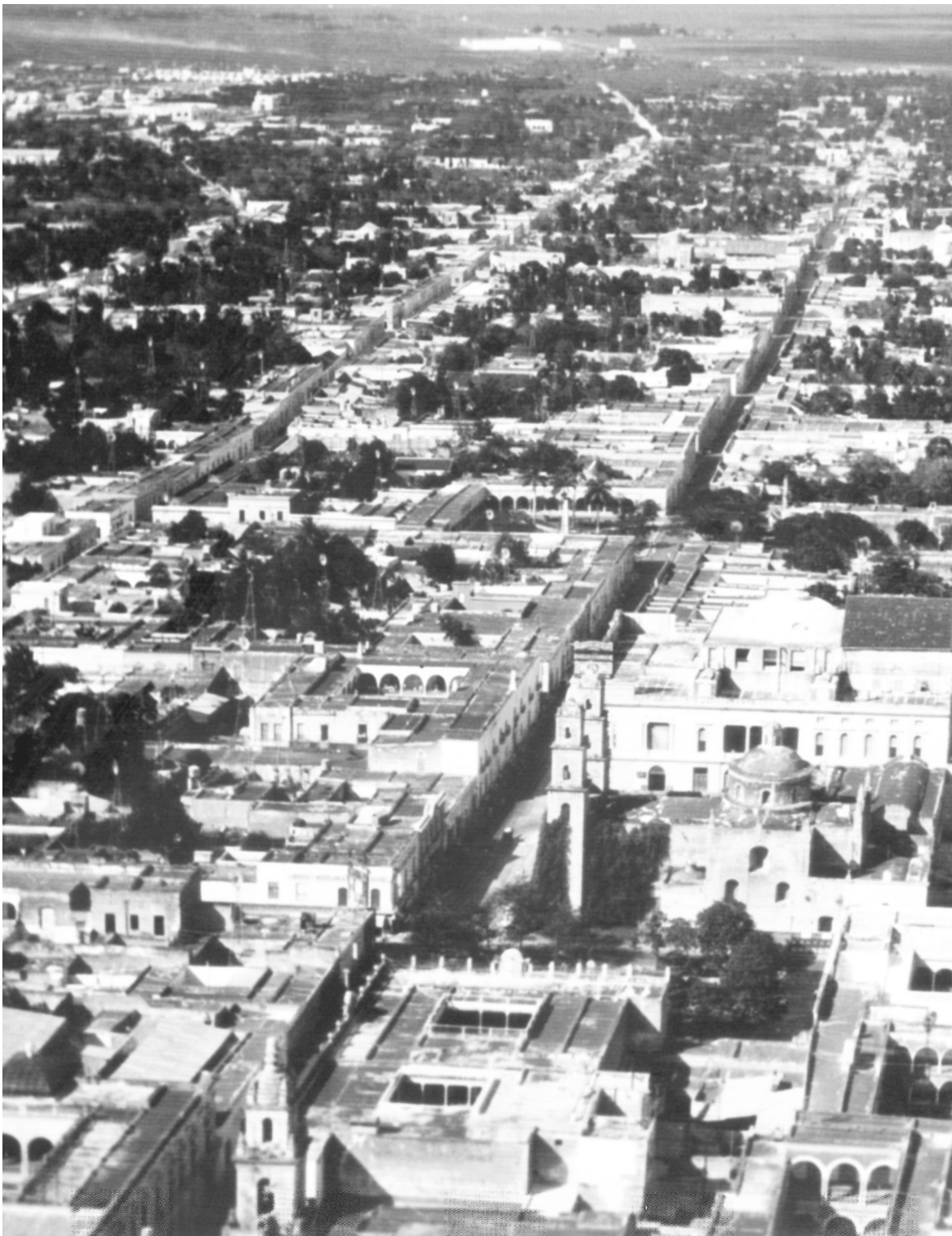
Mérida, vista panorámica hacia el norte de la calle 60, tomada desde la catedral. Puede apreciarse la planta completa del viejo Instituto Literario ya convertida en Universidad Nacional del Sureste, frente al Teatro Peón Contreras. La ciudad mantenía aún su traza colonial, c. 1935. Fuente: "Teatro Peón Contreras: Biografía de un monumento", Carlos Peniche Ponce, coord., México, Libro de Piedra eds., 2008, p. 82.
