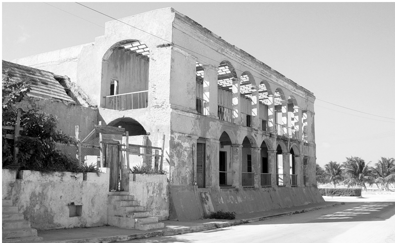
Foto 5. Degradación de "Los Corredores" y de X'kukulyá en general.
