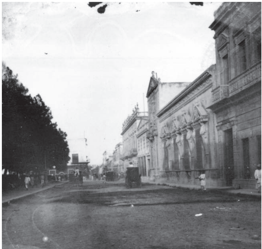
Casa de Montejo. Calle 63 entre 60 y 62, Mérida, Yucatán.
